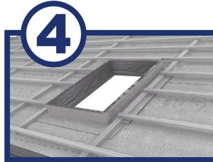
Preklapanja, otvori ili oštećenja na membrani **Ursa** moraju biti sanirani uz pomoć odgovarajuće samolepljive trake. Za spajanje s elementima krova upotrebljava se krovno birtivo ili butilna traka.
