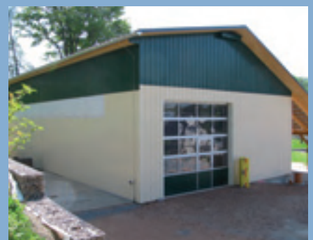
Gewerbekbau auf einer Bodenplatte mit Streifenfundamenten
