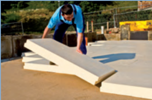
Verlegung der URSA XPS Dämmung auf der Sauberkeitsschicht
