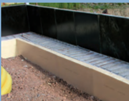
URSA XPS N-III-L in 160 mm unter einer Bodenplatte mit Streifenfundamenten
