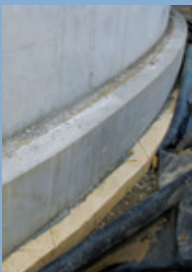
Biogasanlage Ossig (Sachsen) Bodenplatte mit URSA XPS N-V-L
