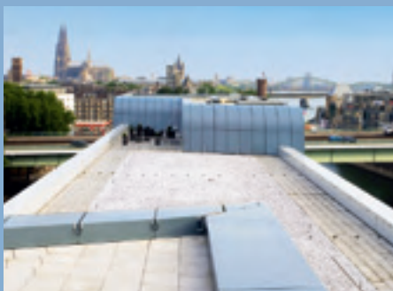
Dämmung am Dach mit URSA XPS
